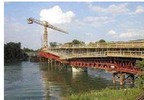
Die neue Brücke bei Laufenburg
